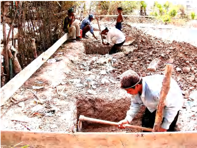
開始直後の基礎工事です。
