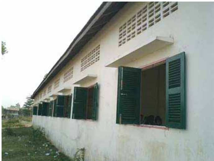
校舎の外から見た窓
