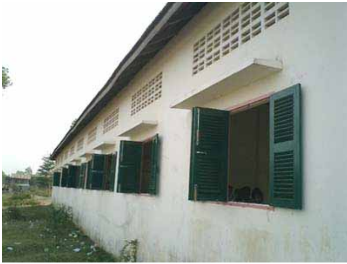
校舎の外から見た窓
